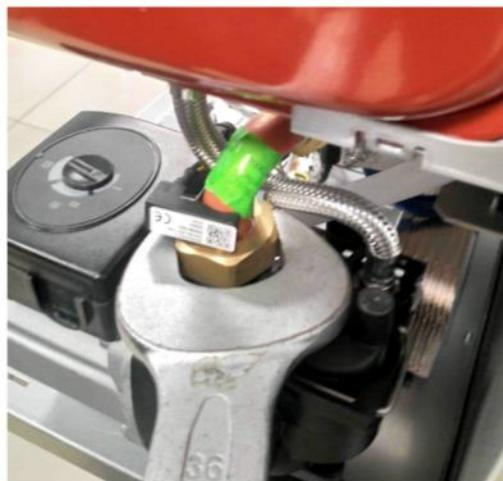
Вентиляционное отверстие насоса можно снять с помощью зажима.
