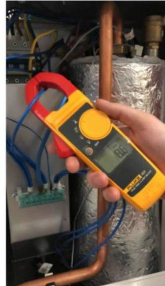
2-Если в тестовом режиме через все резисторы протекает ток, нет необходимости контролировать элементы силовой цепи, такие как материнская плата, релейные платы, резисторы и контакторы. В этом случае необходимо проверить датчики управления и гидрооборудование.
